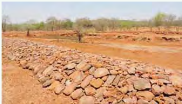
रेस्क्यू क्षेत्र में परकोलेशन टैंक का निर्माण
