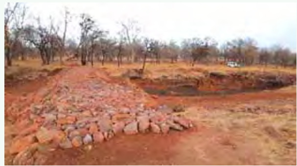
न्यु टाइगर हाउसिंग के सामने परकोलेशन टैंक का निर्माण
